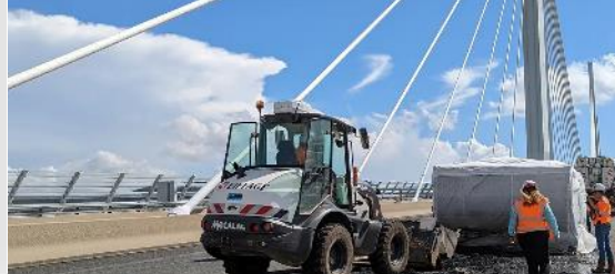
VIADUC DE MILLAU - RÉNOVATION DES CHAUSSEES
