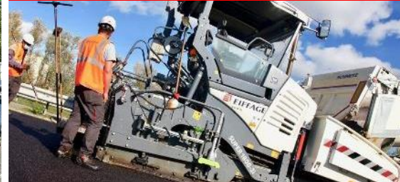
MISE EN ŒUVRE DE BIOPHALT SUR L'A40
