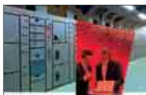
Maintenance multitechnique des tours Mercuriales – Bagnolet
