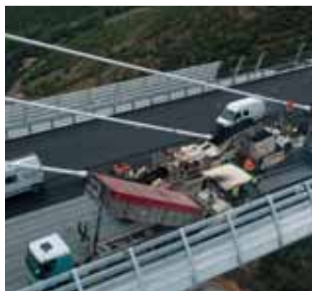
▲ Pose des enrobés sur le viaduc de Millau.
