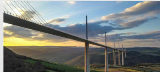
100 % du Viaduc de Millau
