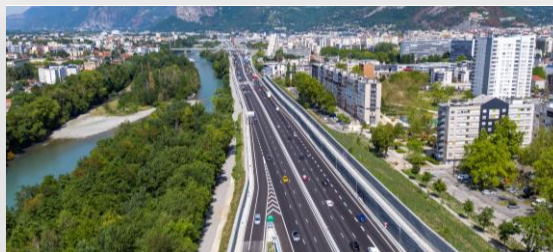
Trafic autoroutier dynamique
